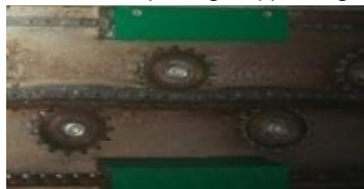
Gambar 4 Sesudah Dipasang Stopper Bagian Rantai
