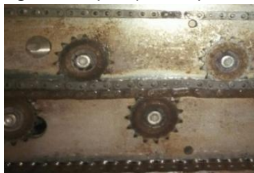
Gambar 3 Sebelum Dipasang Stopper Bagian Rantai
